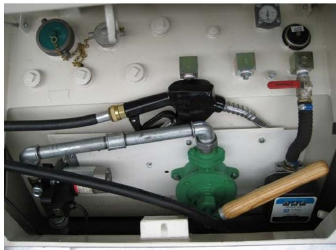
Durch die optionale Ausrüstung mit Armaturen kann der Transportlagertank als Baustellentank nach ADR/RID Vorschriften eingesetzt werden.
